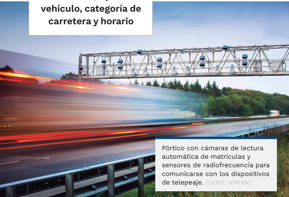
Pórtico con cámaras de lectura automática de matrículas y sensores de radiofrecuencia para comunicarse con los dispositivos de telepeaje. FUENTE: VITRONIC
